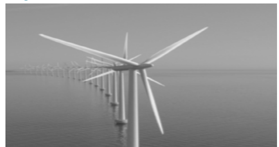
Ventiladores, utilización de energía eólica
